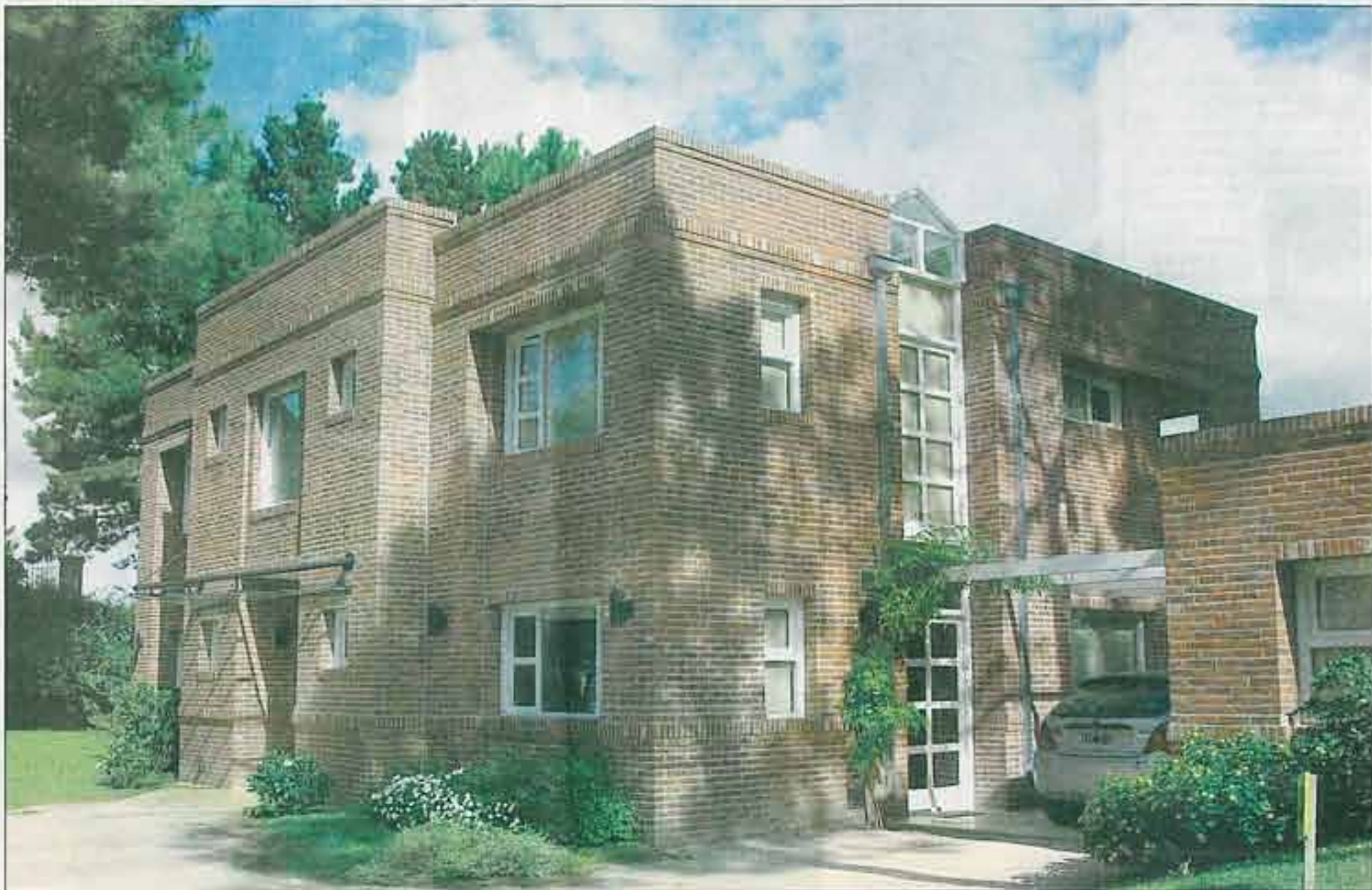
El frente sobre la calle de la vivienda en Pinamar, con su contundente volumetría de ladrillo visto, pérgola y bloque para huéspedes
